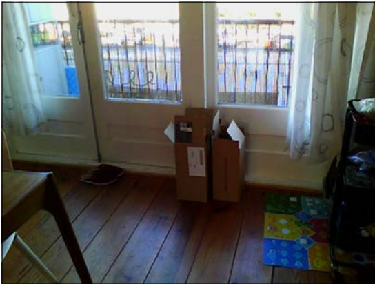
De openslaande deuren in de bovenwoning aan de noordzijde. De beglazing vormt in deze ruimte een koude wand.
