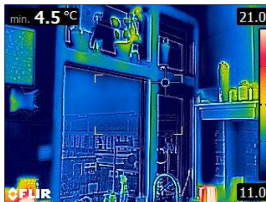
De raampartij in de keuken van de bovenwoning. Twee kwaliteiten beglazing zijn te zien op de warmtefoto, links HR++ glas (in lichtblauw), het overige glas is regulier dubbel glas.
